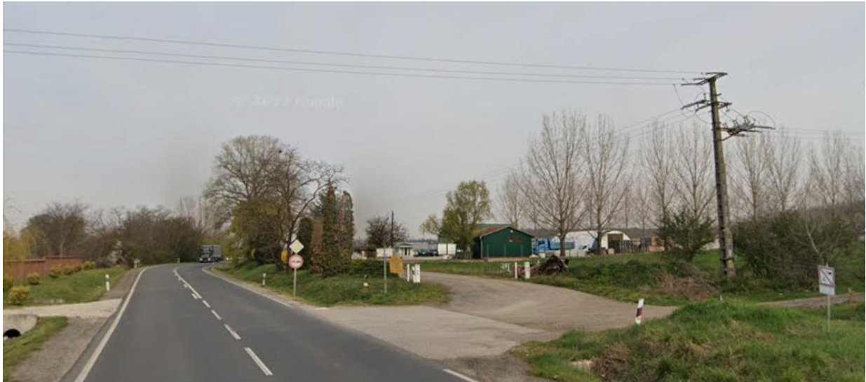
0171/57,58 hrsz telkének és a 0178/5 hrsz villanytelep közös közúti bejárója a 31.sz. útról
