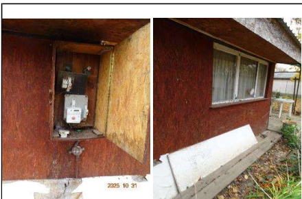
Villanyóra / faház homlokzata
